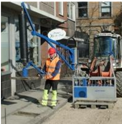
Figur 11 – vakuumlift
