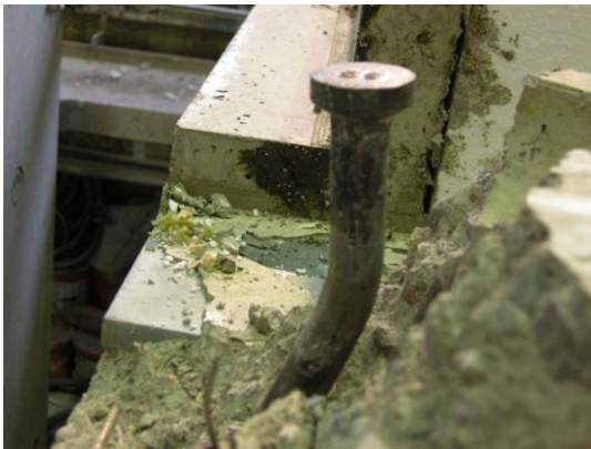
Figur 2.1.2– Frilagd lyftinfästning
